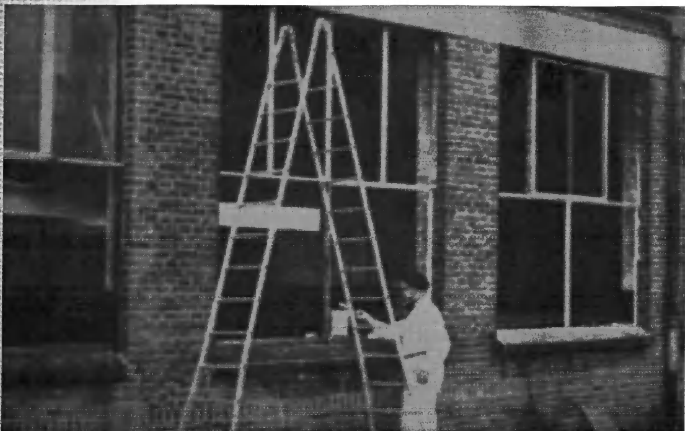
Louis Maas voorziet de kozijnen van het Mierlose bedrijf van een eerste laag grondverf.
