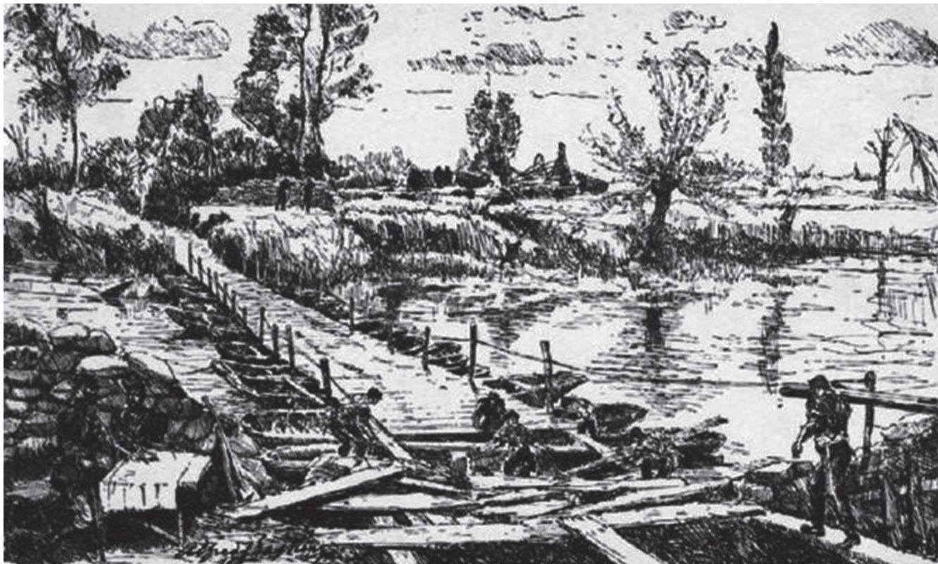
Met allerlei beplating werd er een noodbrug gemaakt.
